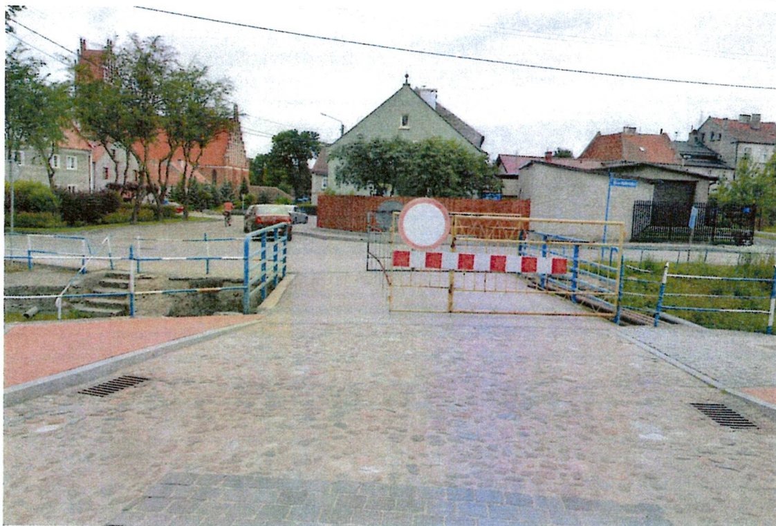
Fot. 1. Widok mostu z góry.
