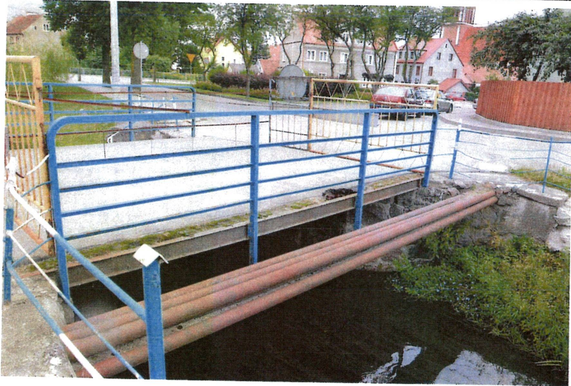
Fot. 3. Widok mostu od strony napływu. Widoczne urządzenia obce.
