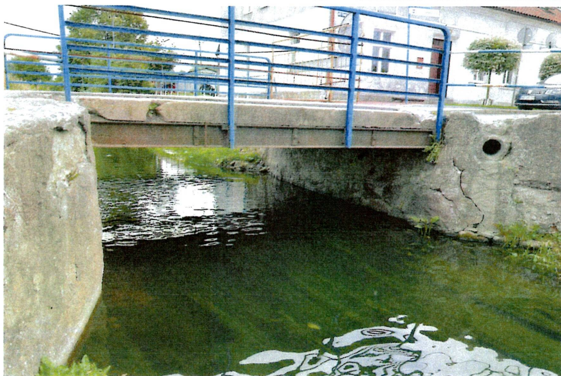
Fot. 2. Widok mostu od strony odpływu.
