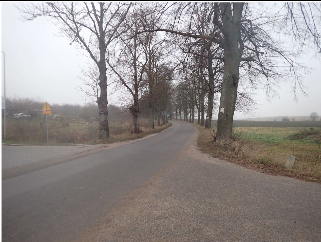
Zdj.2. Widok na obszar sąsiedztwo obszaru opracowania od strony południowej w kierunku zachodnim – ul. Sienkiewicza.
