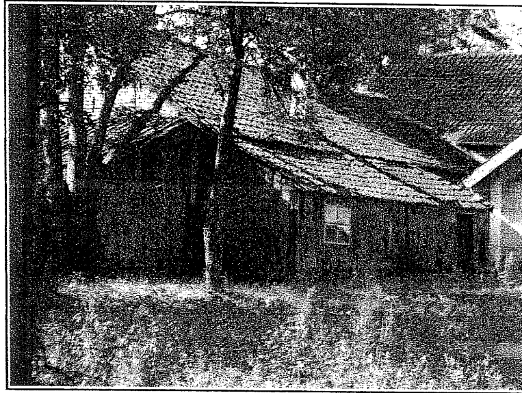
■ BUDYNEK ŚWIETLICY ELEWACJA PÓLNOCNA
