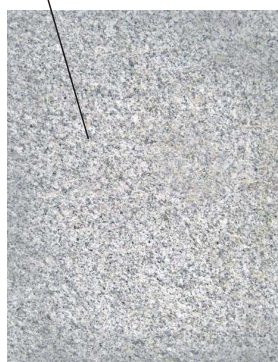
schody obłożone płytą granitową płomieniowaną
