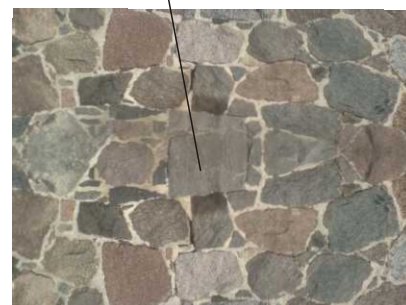
kamień polny łupany do obłożenia wszystkich murków oporowych
